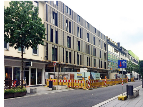
Diese Baustelle ist gerade Mal ein Jahr her
